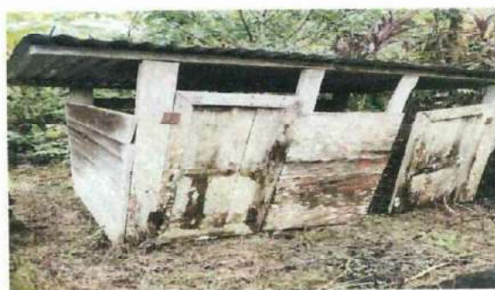
Foto 4: Panoramica de baños.
